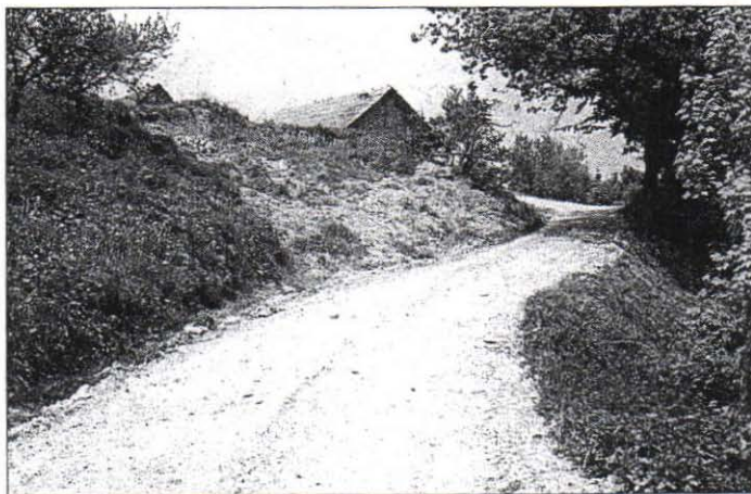
Kolednikov plaz je največji v občini. Cesta, ki povezuje Biški Vrh s Trnovsko vasjo, je trenutno uspešno sanirana
